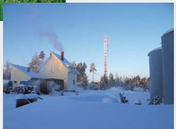
Abb. 11. Hohe Türme können für großräumige und langzeitliche Messungen von \text{CO}_2 und anderen Spurenstoffen benutzt werden. Im Bild zu sehen ist der Turm ZOTTO (Zotino Tall Tower Observatory), ein im Bau befindlicher neuer 300 m hoher Beobachtungsmast in Zentralsibirien (nahe 60^\circ\text{Nord} , 90^\circ\text{Ost} ), der in Kooperation zwischen drei MPI's und des Russian Institute of Forest, Krasnoyarsk entsteht (Photo: Y. Kisilyakhov).
